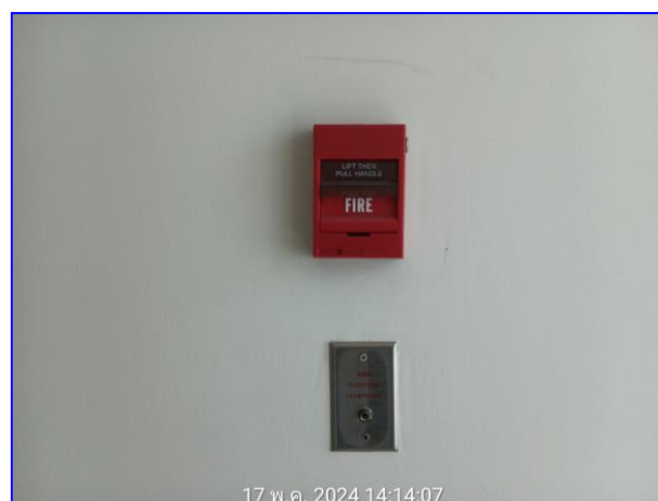
รูปที่ 2.33 Fire Alarm
