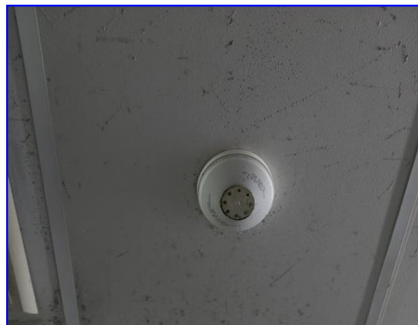
รูปที่ 2.32 เครื่องตรวจจับความร้อน
